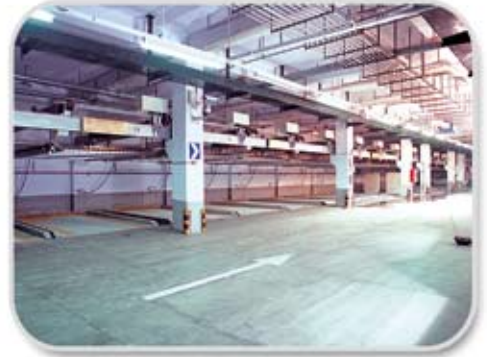
乌鲁木齐鸿福大酒店 PSH-3K升降横移式 45车位 Urumchi Hongfu Hotel PSH-3K Lift-sliding parking system—having 45 parking seats
